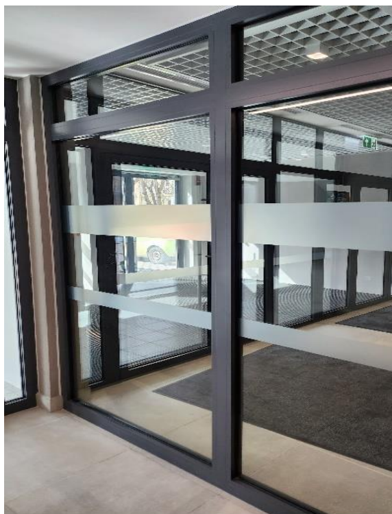
Rysunek 16. Zdjęcie oznaczenia przeszkleń w budynku C-7 AGH
