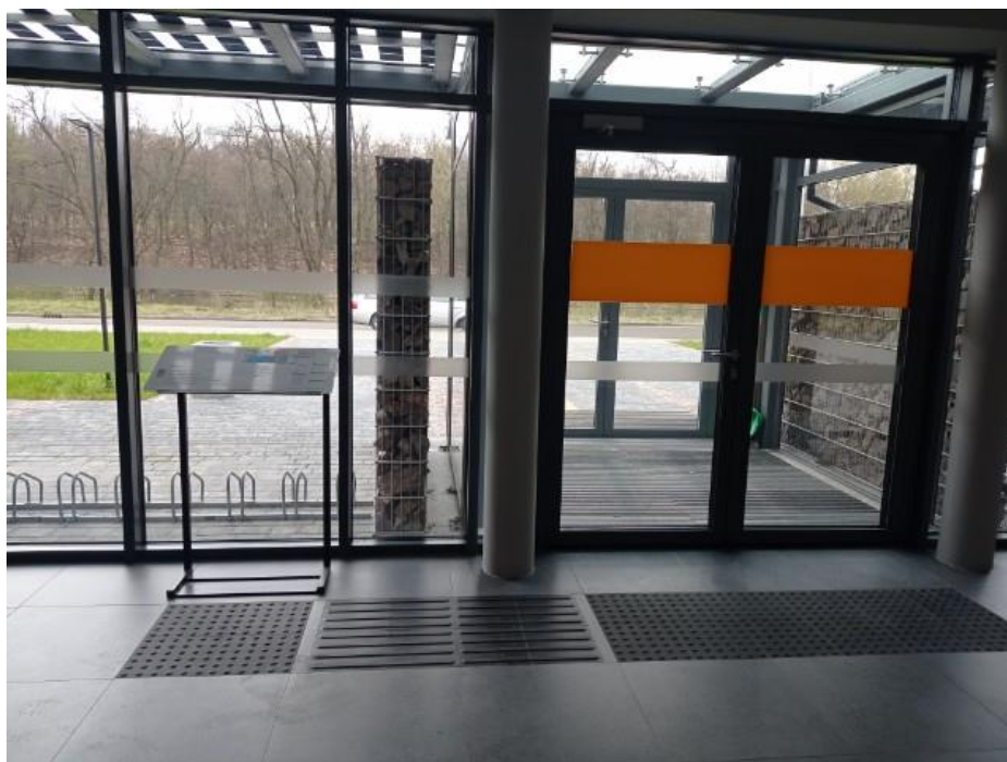
Rysunek 48. Zdjęcie ścieżki FON prowadzącej do planu tyflograficznego
