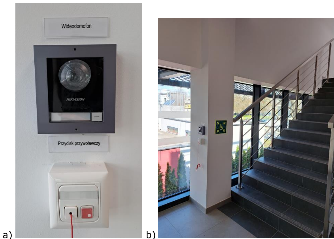
Rysunek 52. a) Zdjęcie wyposażenia miejsca oczekiwania na uratowanie w budynku SCK, b) Zdjęcie miejsca oczekiwania na uratowanie w budynku SCK
