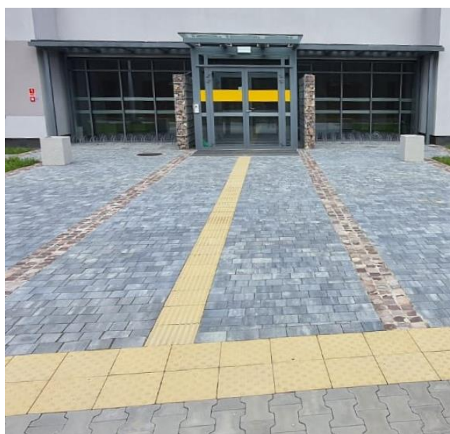
Rysunek 9. Zdjęcie elementów systemu FON przed wejściem do budynku Centrum Zrównoważonego Rozwoju i Poszanowania Energii AGH w Miękinii
