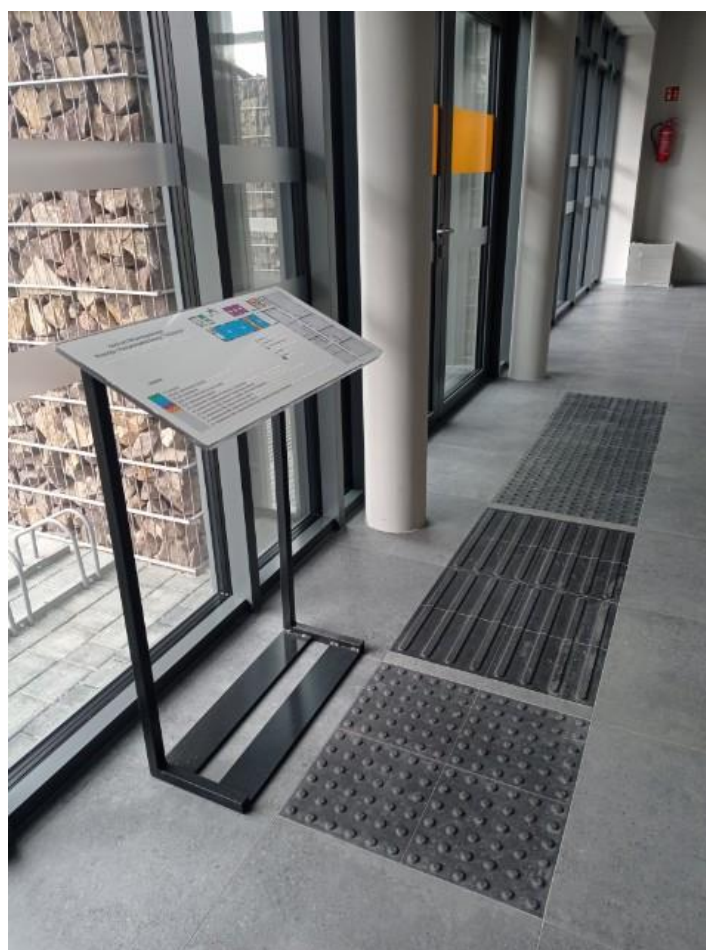
Rysunek 49. Zdjęcie ścieżki FON prowadzącej do planu tyflograficznego
