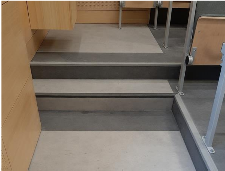
Rysunek 56. Zdjęcie przykładowego oznaczenia schodów w sali wykładowej
