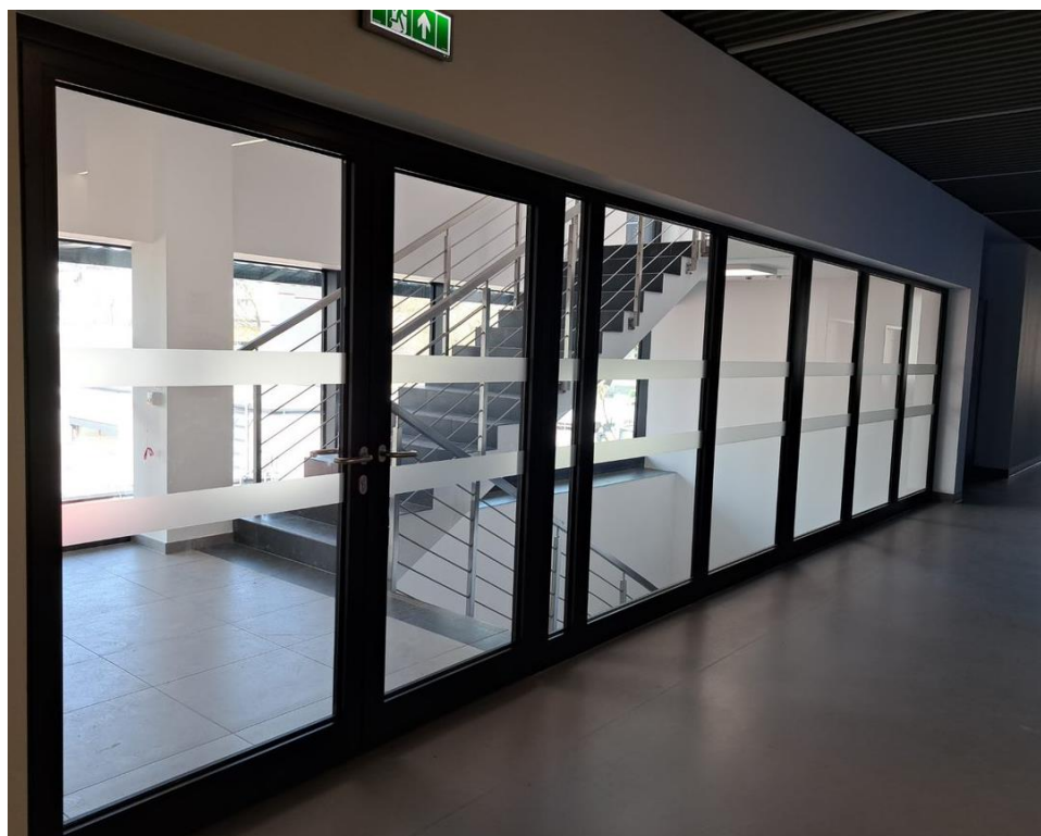
Rysunek 15. Zdjęcie oznaczenia przeszkleń w budynku SCK AGH
